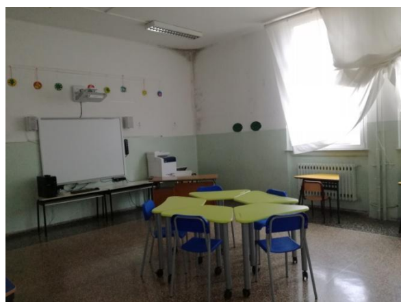
Figura 4.2 - Particolare delle zone con muffe nell'aula digitale al quarto piano.
