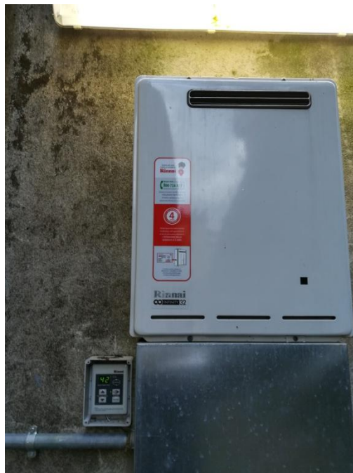
Figura 4.15 - Particolare della caldaia murale per produzione di ACS a servizio della cucina
