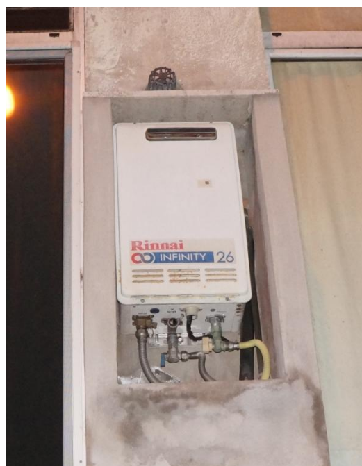
Figura 4.15 - Particolare della caldaia murale per produzione di ACS a servizio della cucina
