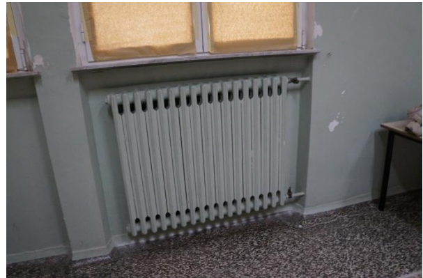
Figura 8.7 – Particolare terminali di emissione
