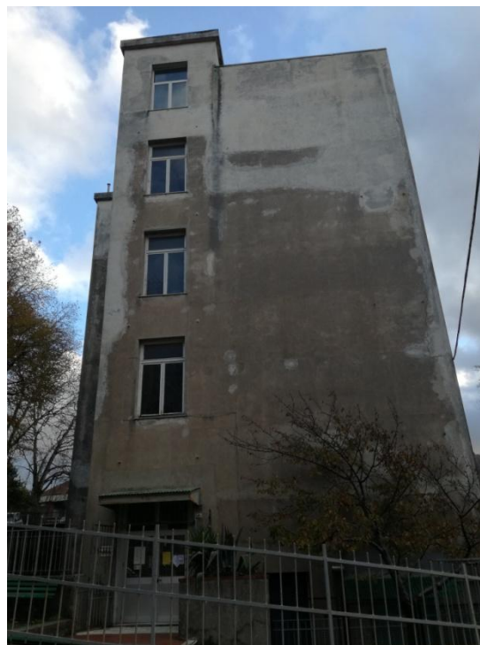
Figura 1.1 - Vista delle facciate sud-ovest
